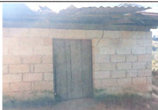
Foto 2: ESTA IMAGEN MUESTRA LA AGRETADURA DE LAS PAREDES Y EL DETERIORO DE LA PUERTA
