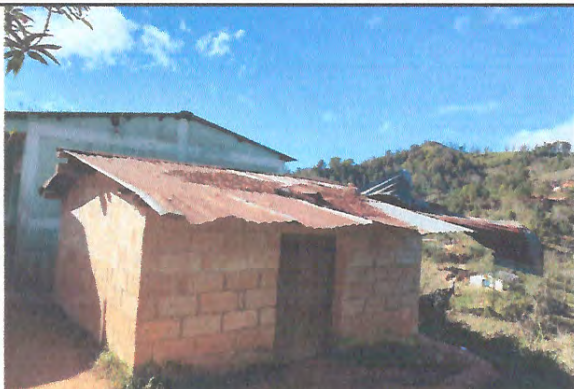
Foto 1: ESTA IMAGEN NOS MUESTRA EL DETERIORO DEL TECHO, DEL LUGAR QUE SE UTILIZA COMO COSINA
